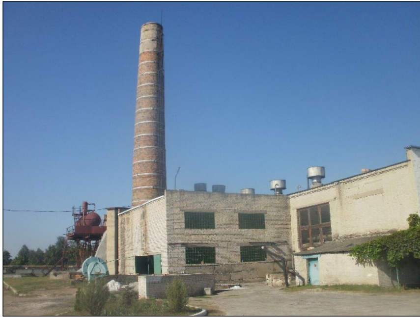
Рисунок 2.7 – Здание существующей котельной на природном газе
