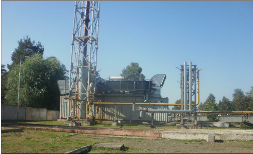
Рисунок 2.10 – Когенерационная установка (КГУ) СНР3516С
